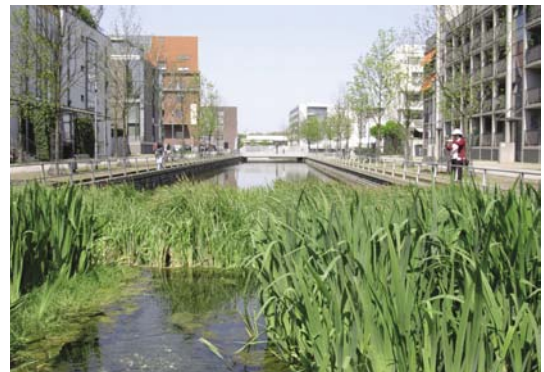
Ein Regenwasserkanal im Duisburger Innenhafen
