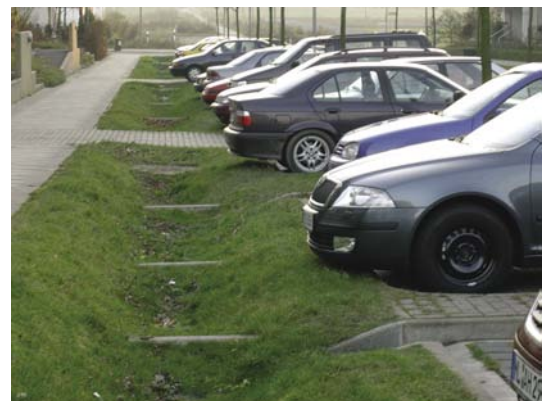
Mulden zum Rückhalt des Regenwassers im Straßeraum
